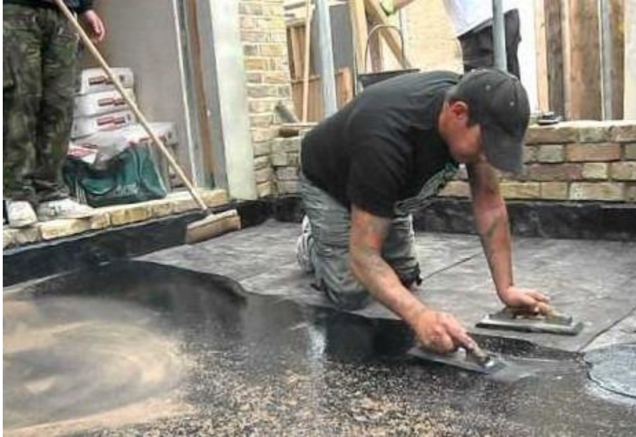
Fig: Asphalt Flooring
